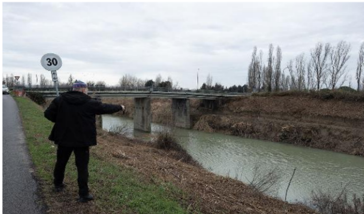
Lavori sul fiume Ronco a Ghibullo, prima d'ora mai così radicali. Ma senza manutenzione in collina, non basta (Foto Zani)
